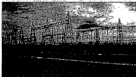
สถานโกไฟฟ้า
